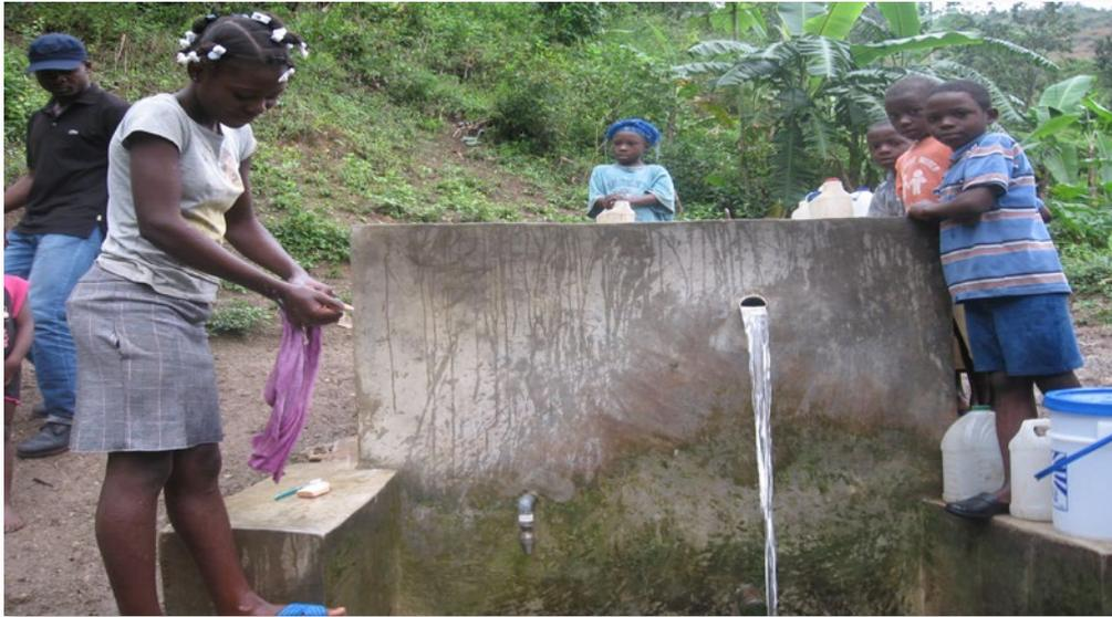
El proyecto consistió en canalizar el agua hasta un punto en el que se instalara una fuente protegida del agua de lluvia, desechos y animales, donde sacar agua potable, completando el trabajo con una zona, que no afectase a la fuente, para lavado de la ropa con agua limpia que evitase problemas de parásitos.
